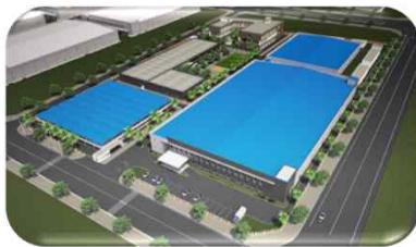
[베트남 2공장, 빈] 2,600명 부품(SPK,RCV), CELL/자동차 Line
