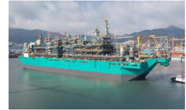
LNG FPSO "SATU"
