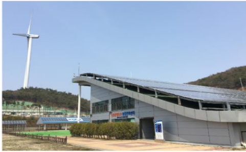
남동발전 영흥 풍력 연계 (규모 : 4MW/16MWh)
