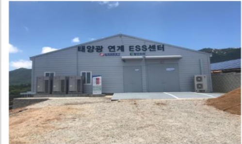
한전 영암 태양광 연계 (규모 : 6MW/26MWh)
