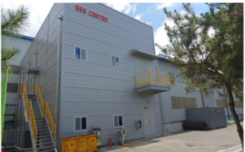
대한제강 녹산공장 피크저감용 (규모 : 4MW/24MWh)
