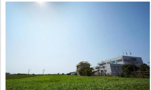
한전 가파도 마이크로 그리드용 (규모 : 3MW/3MWh)
