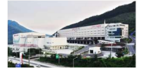
L' Distribution Center
