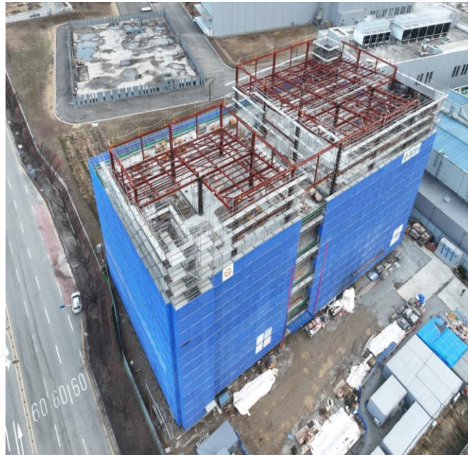
'23년 12월 공장 전경
