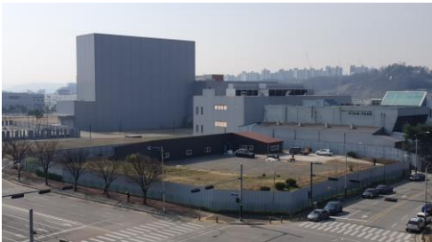
'23년 4월 공장 전경
