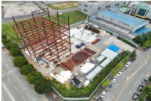
'23년 8월 공장 전경
