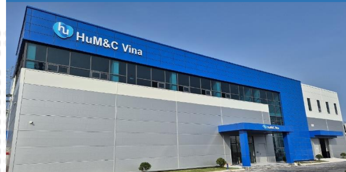
휴엠앤씨Vina 베트남 현지 공장 건립
