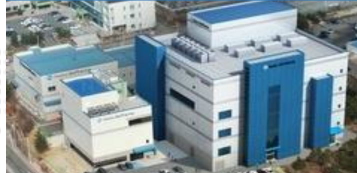
휴온스바이오파마 C동(3공장) 신규 라인 증설
