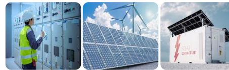
배전반 태양광 발전시스템 ESS
