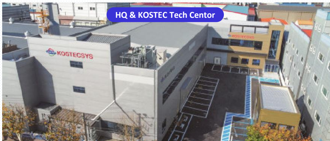
인천광역시 남동구 논현동 428-4 대지(3,294㎡), 건물(4,526㎡)
