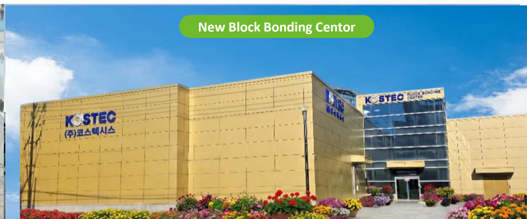
인천광역시 남동구 논현동 429-12 대지(3,308㎡), 건물(3,361㎡)
