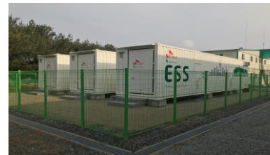
C&I ESS 770MWh
