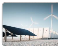
태양광 연계 ESS
