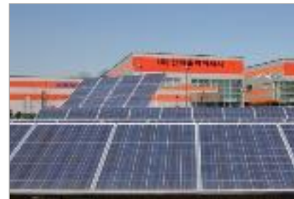
3. 태양광 모듈공장 충청북도 음성군
