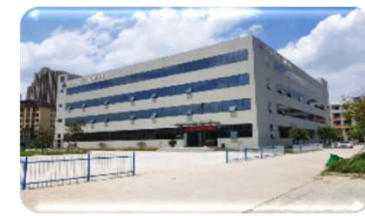
[중국 푸양 공장] 300명 진동 Motor
